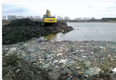
Práce na skládke
