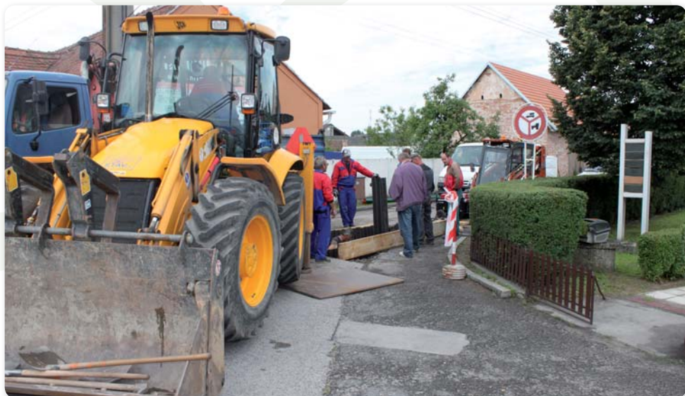
Budovanie stokovej siete
