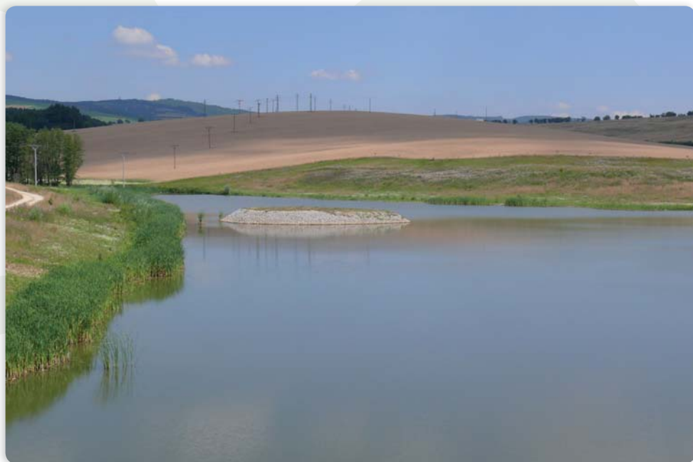
Pohľad na zrealizovaný polder
