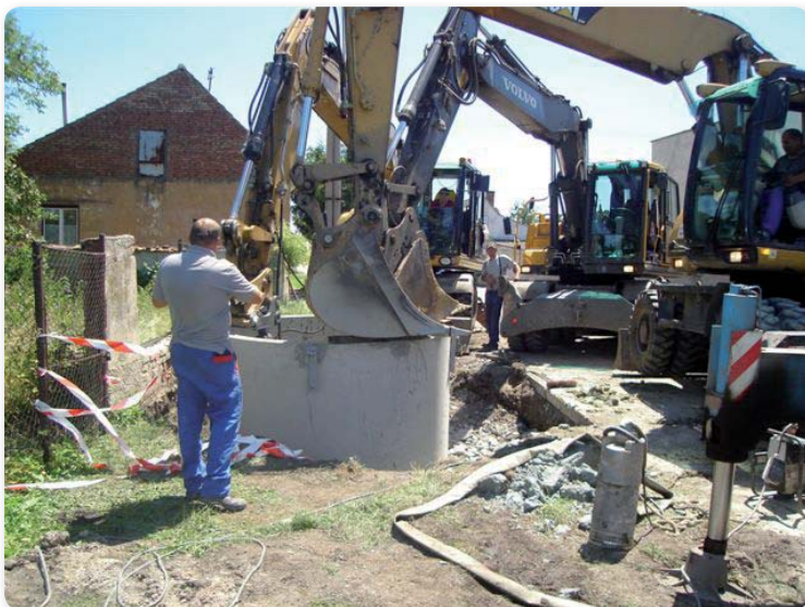
Osádzanie kanalizačnej šachty
