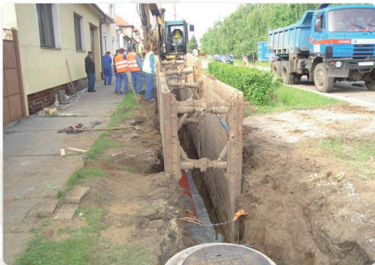
Výkopové práce počas realizácie stavby
