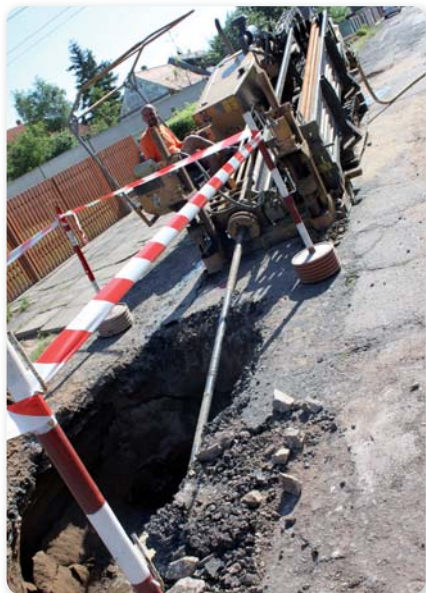
Výkopové práce počas realizácie projektu
