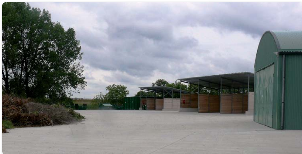
Pohľad na Eko dvor a kompostáreň po realizácii
