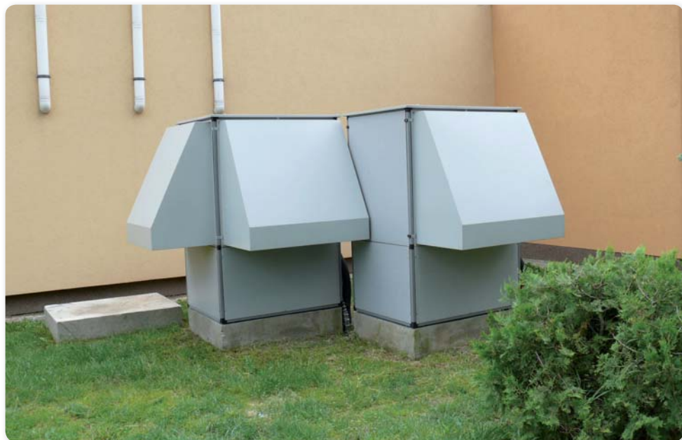
Tepelné čerpadlá v areáli školy
