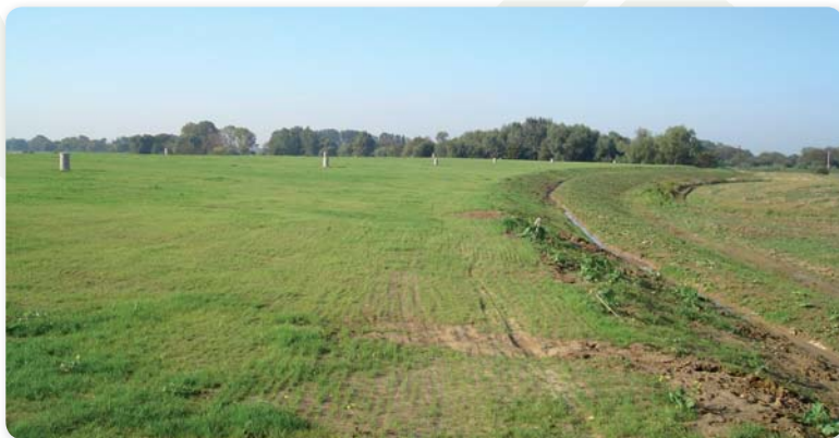
Pohľad na zreklamovanú skládku TKO a plynové odvetrávače
