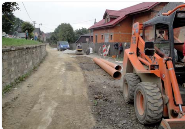
Realizácia výstavby kanalizácie
