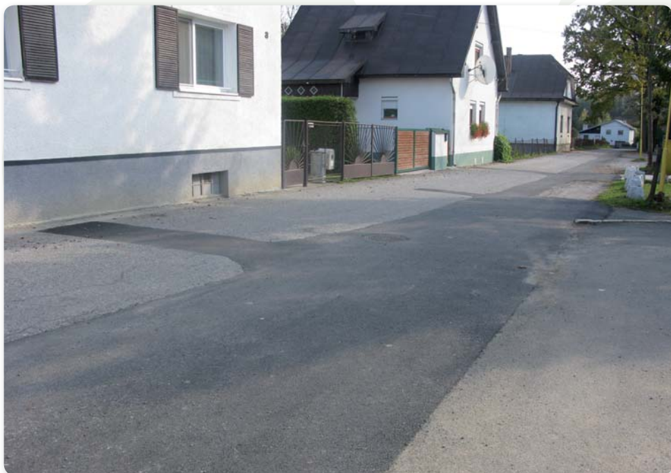
Ukončenie výstavby časti stokovej siete
