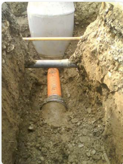
Pohľad na kanalizačné potrubie a šachtu
