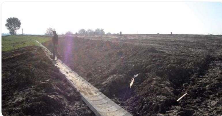
Budovanie odvodňovacieho rigolu
