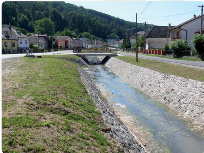
Upravené koryto Hlbokého potoka
