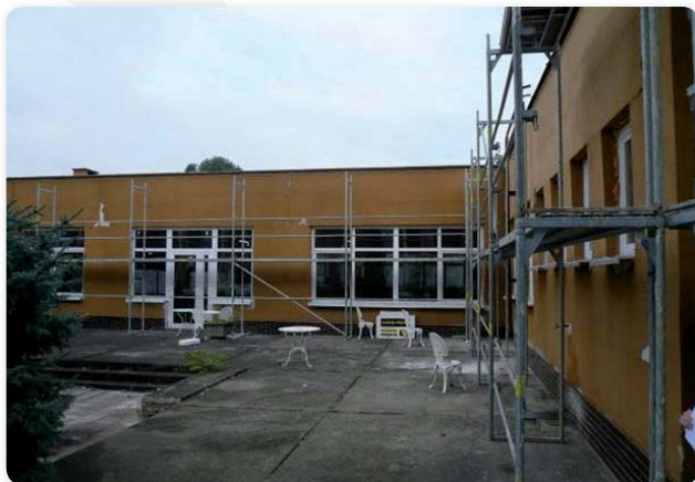
Práce počas realizácie projektu
