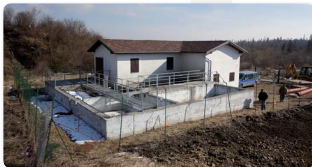
Realizácia výstavby ČOV
