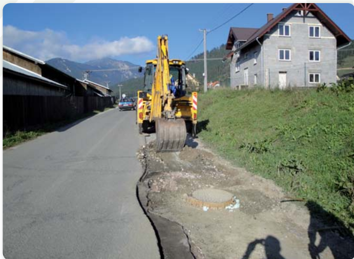
Realizácia výstavby kanalizácie
