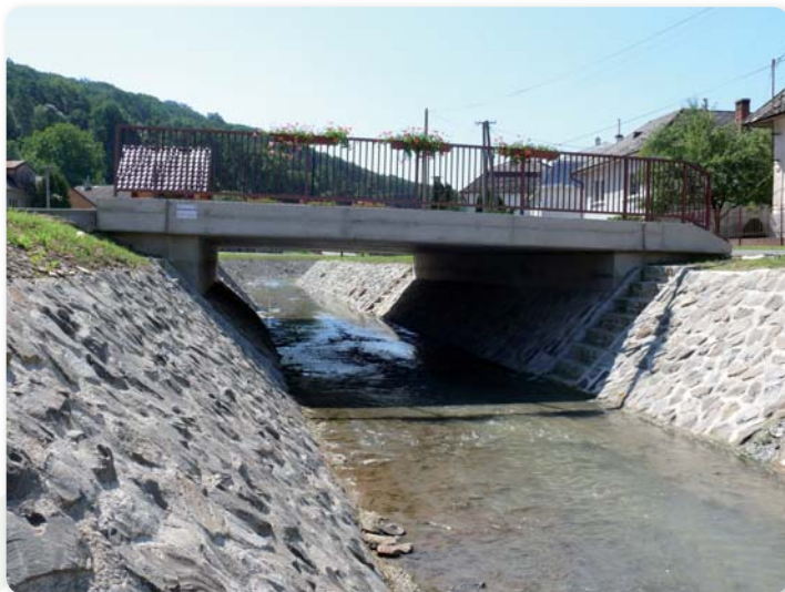
Premostenie upraveného Hlbokého potoka
