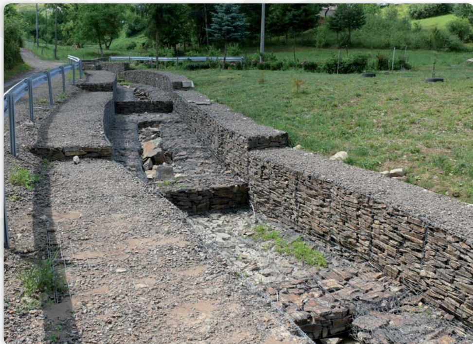
Stabilizované koryto Inovského potoka
