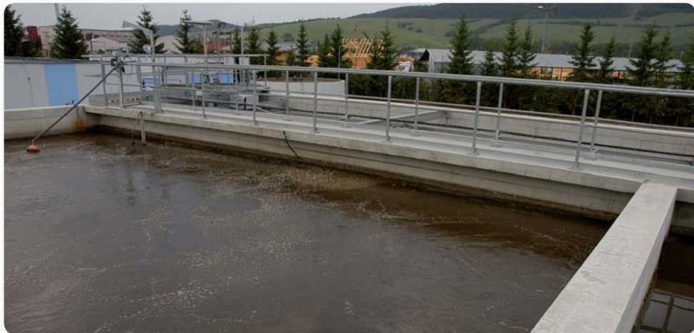
Proces čistenia odpadových vôd
