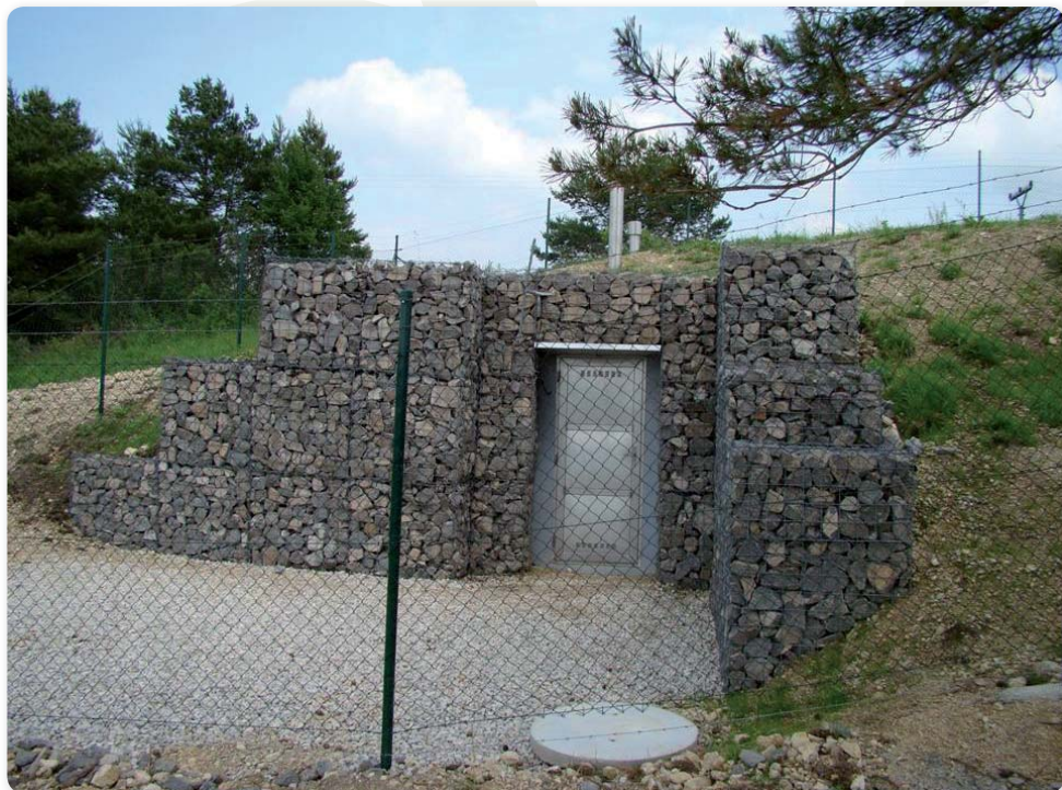
Vybudovaný zásobník na vodu – vodojem
