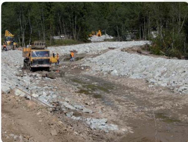
Úprava koryta toku a spevňovanie brehov
