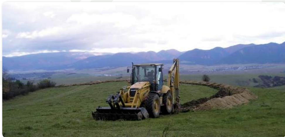
Výkopové práce počas budovania vodovodnej siete
