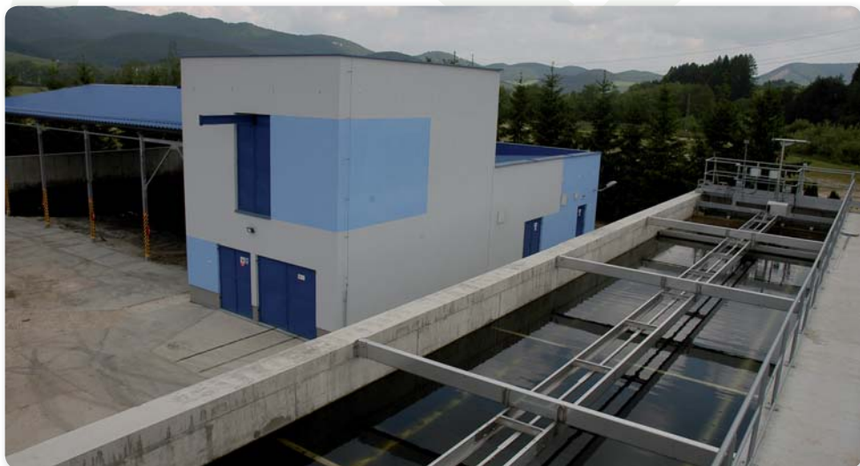
Čistička odpadových vôd
