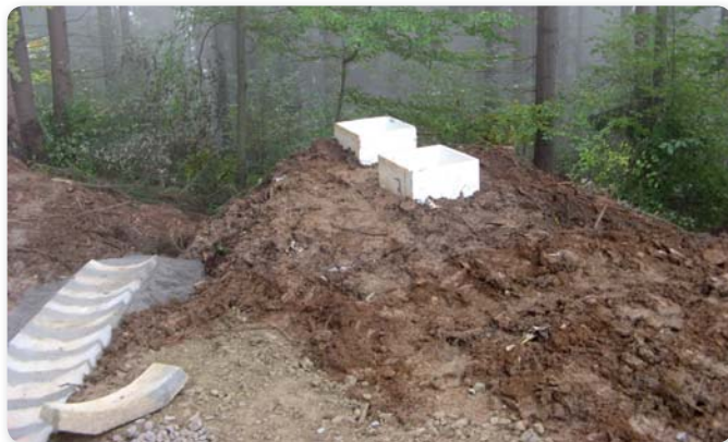
Práce na skládce PDO
