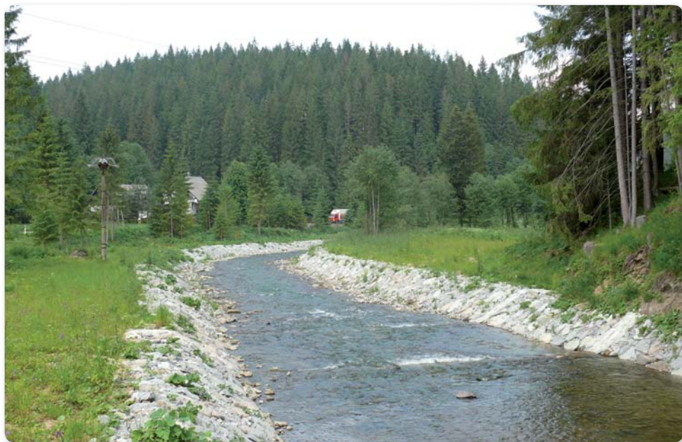
Stabilizované koryto toku Oravica
