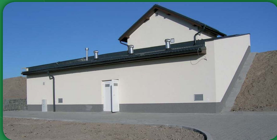
Názov projektu: Dobudovanie kanalizácie a vodovodu v aglomerácii Veľká Lomnica a Vysoké Tatry Názov žiadateľa: Podtatranská vodárenská spoločnosť, a.s. Celkové náklady projektu: 5 601 074,38 € Poskytnutý finančný príspevok: 5 321 020,66 €
