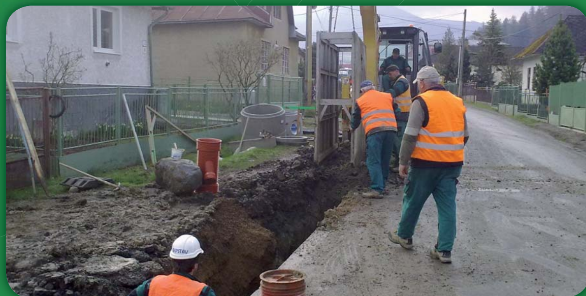
Názov projektu: Zemplínske Hámre - kanalizácia Názov žiadateľa: Východoslovenská vodárenská spoločnosť, a.s., Košice Celkové náklady projektu: 3 456 286,27 € Poskytnutý finančný príspevok: 3 283 471,96 €
