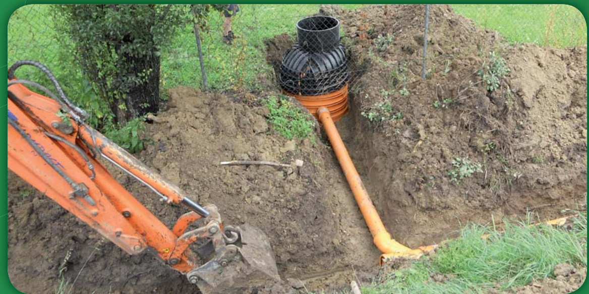
Názov projektu: Sobrance, ul. Michalovská - rozšírenie kanalizácie II. Názov žiadateľa: Mesto Sobrance Celkové náklady projektu: 818 406,86 € Poskytnutý finančný príspevok: 777 486,52 €
