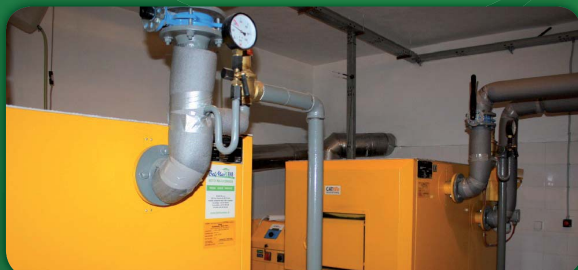
Názov projektu: Zmena palivovej základne v prospech biomasy a zníženie energetických strát budovy Kultúrneho domu v Margecanoch Názov žiadateľa: Obec Margecany Celkové náklady projektu: 906 846,81 € Poskytnutý finančný príspevok: 861 504,47 €
