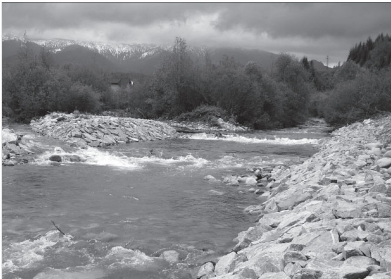
Stabilizácia koryta Studeného potoka v Habovke
