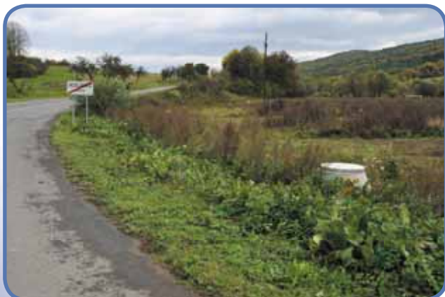
• Kanalizácia v Medzilaborciach časť Borov
