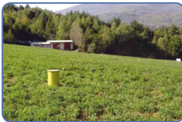
• Pohľad na zrekultivovanú skládku TKO a plynové odvetrávače
