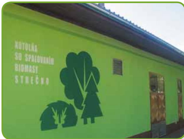
• Kotolňa so spaľovaním biomasy Strečno
