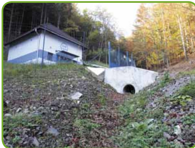
• Budovanie čerpacej stanice
