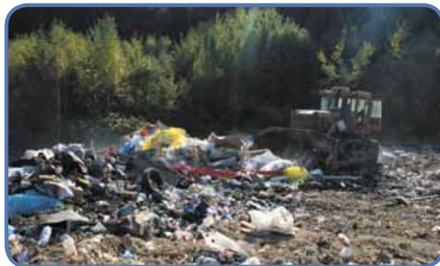
• Práce na skládke TKO
