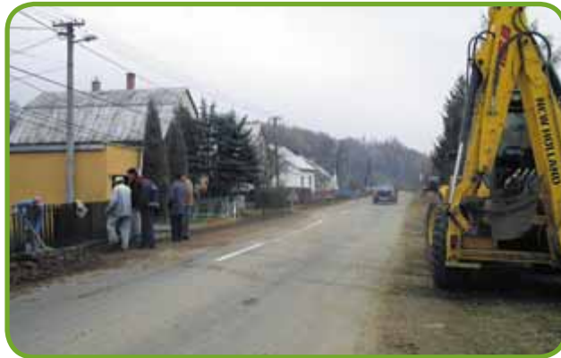
• Výkopové práce počas realizácie projektu
