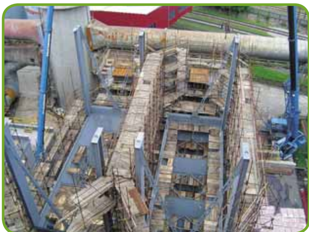
• Výstavba elektrostatických odľučovačov
