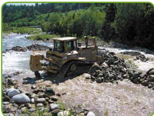
• Úprava toku s pomocou ťažkej techniky
