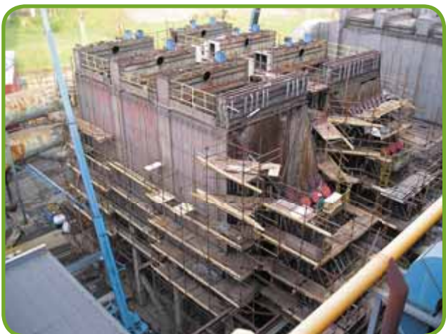
• Výstavba elektrostatických odľučovačov
