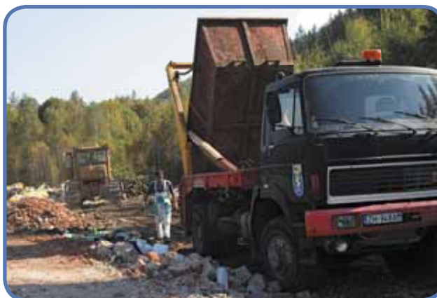
• Práce na skládke TKO
