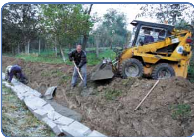
• Budovanie odvodňovacieho rigolu
