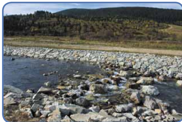
• Koryto stabilizované prahom z drevenej guľatiny a kameným záhozom.
