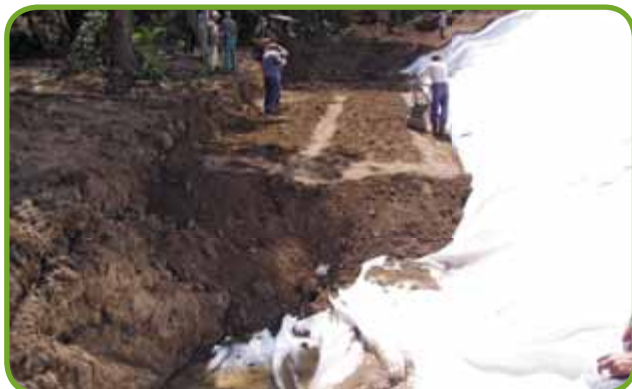
• Tesnenie podložia a hrádze
