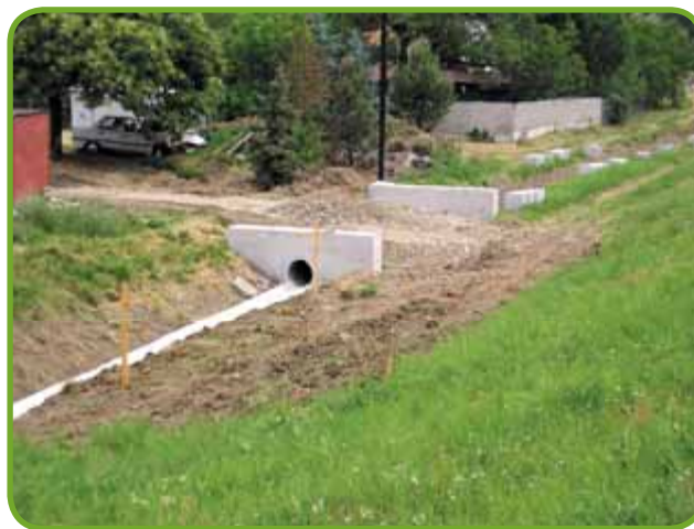
• Priepust pod prístupovou cestou
