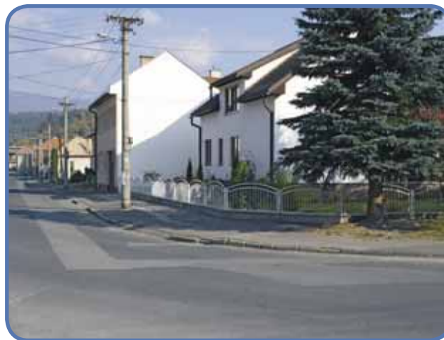
• Pohľad na ulicu, kde je umiestnené potrubie na zásobovanie vody
