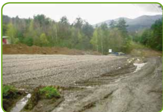
• Navážanie rekultivačnej vrstvy zeminy
