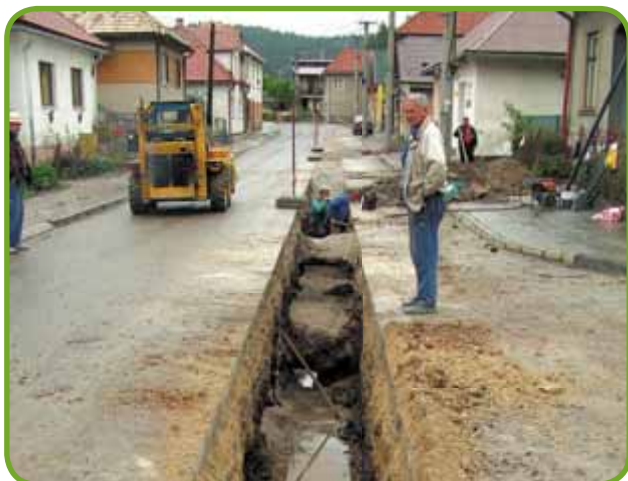
• Budovanie vodovodnej siete
