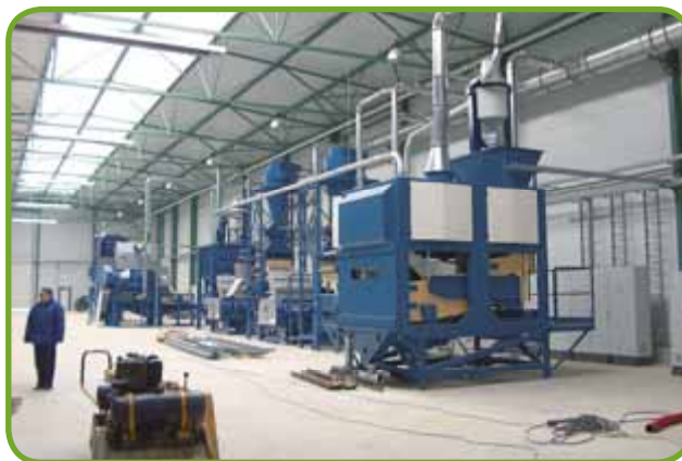
• Montáž technologického zariadenia
