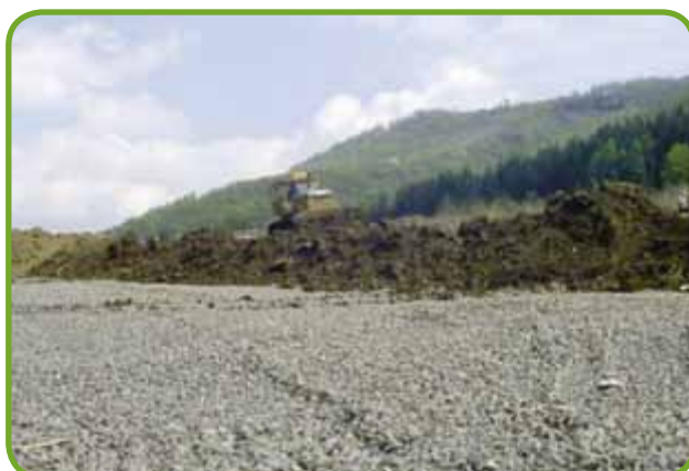
• Navážanie rekultivačnej vrstvy zeminy
