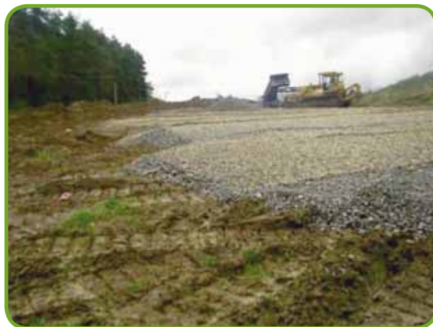
• Navážanie odplyňovacích štrkov
