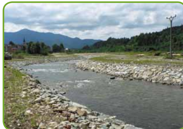
• Stabilizované koryto Habovky
