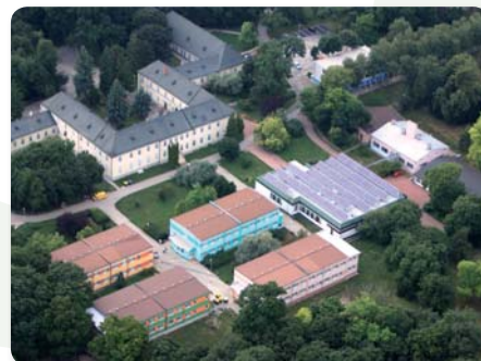
Pohľad na umiestnenie solárnych kolektorov v areáli PsN Veľké Zálužie
