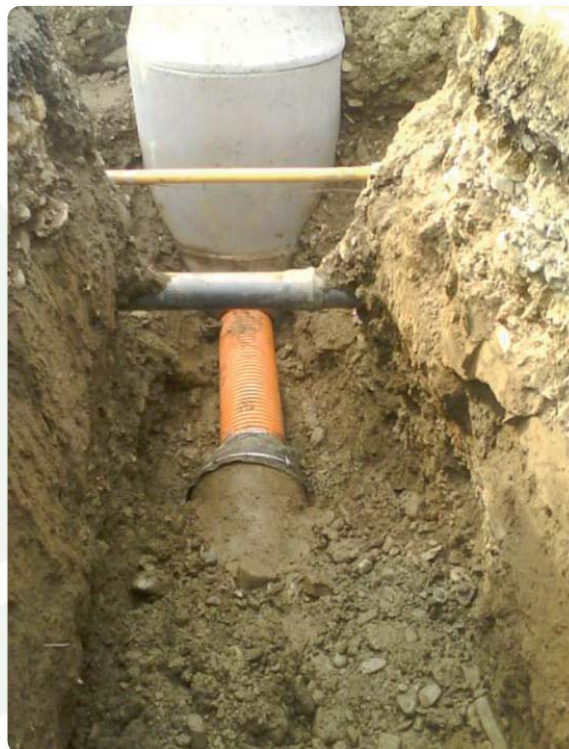
Pohľad na kanalizačné potrubie a šachtu
