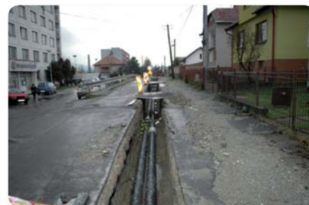
Rekonštrukcia a výstavba rozvodov tepla
