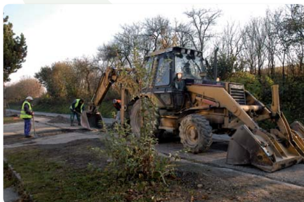
Realizácia výstavby kanalizačnej siete
