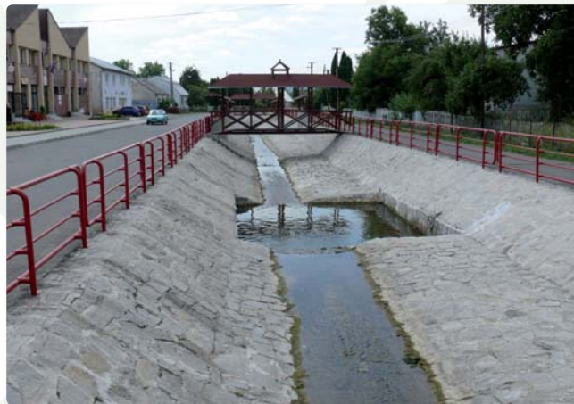
Pohľad na zrekonštruované premostenie cez vodný tok Rokytovec
