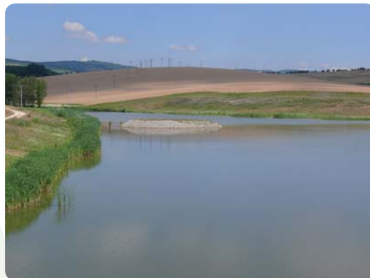
Pohľad na zrealizovaný polder
