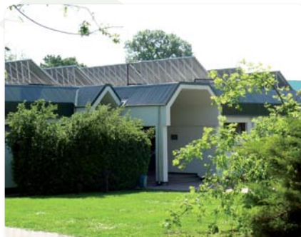
Inštalované slnečné kolektory
