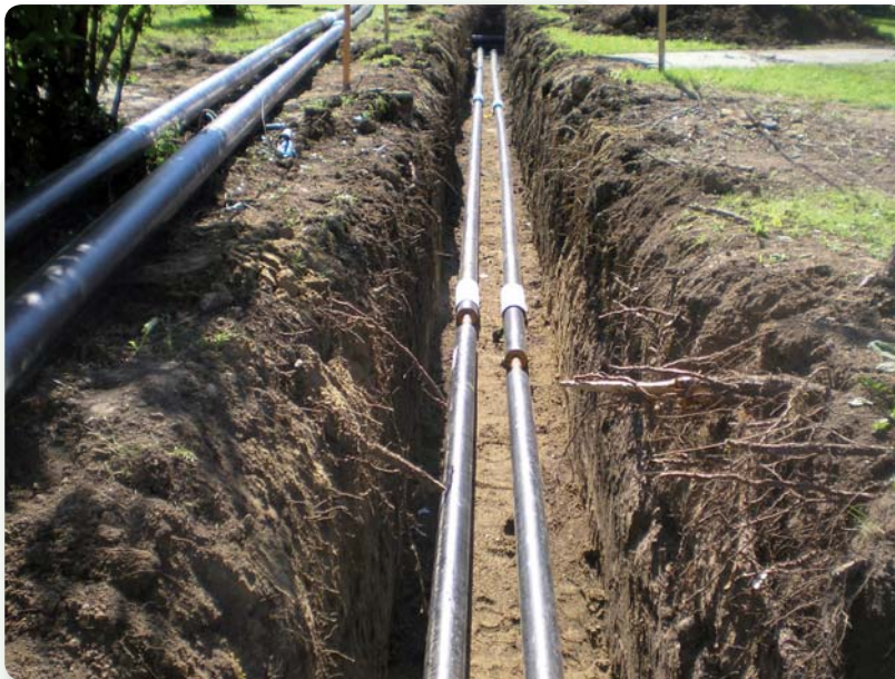
Výstavba a rekonštrukcia rozvodov tepla
