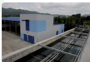
Čistiareň odpadových vôd
