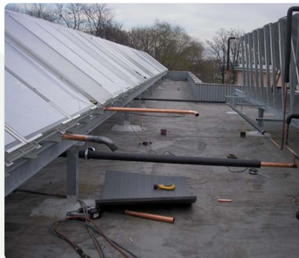
Práca na inštalácii solárnych panelov
