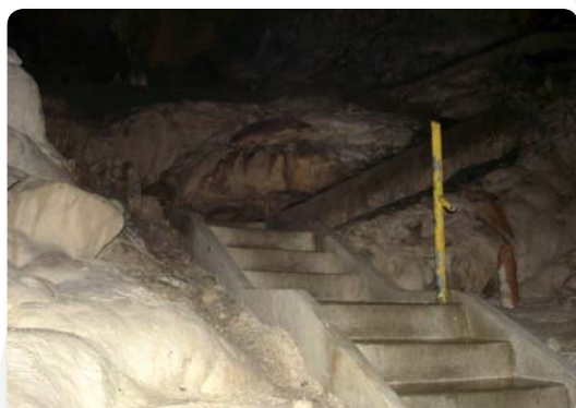
Realizácia rekonštrukčných prác
