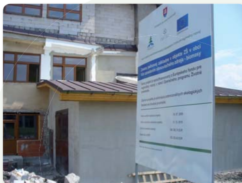
Rekonštrukcia kotolne na biomasu
