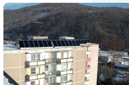
Pohľad na solárne kolektory umiestnené na bytovom dome
