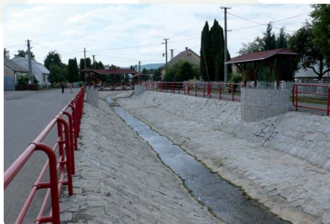
Regulácia vodného toku Rokytovec v zastavanom území obce
