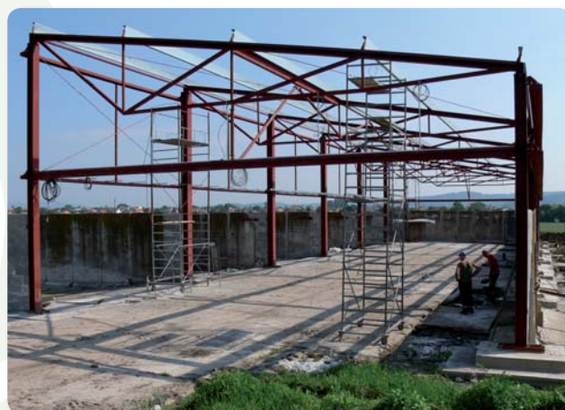
Výstavba zastrešenia časti dekontaminačnej plochy
