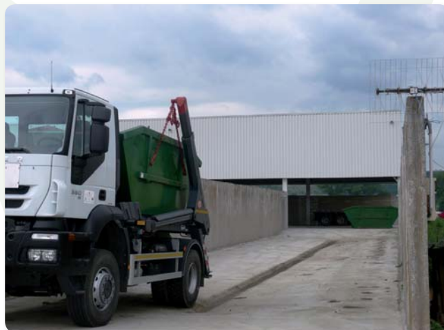
Dekontaminačná plocha a zvozové vozidlo
