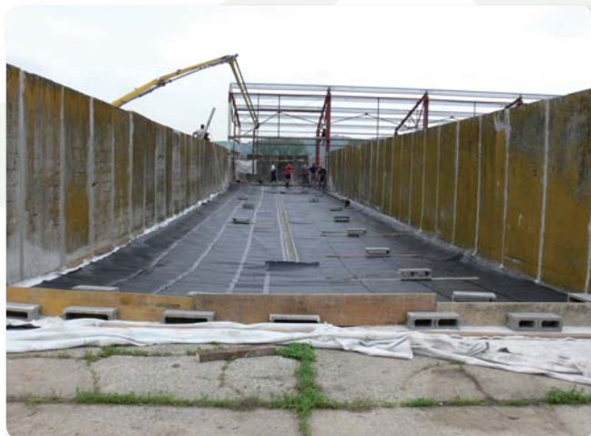
Výstavba dekontaminačnej plochy
