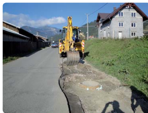
Realizácia výstavby kanalizácie
