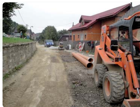
Realizácia výstavby kanalizácie
