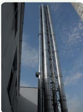
Pohľad na komínové teleso
