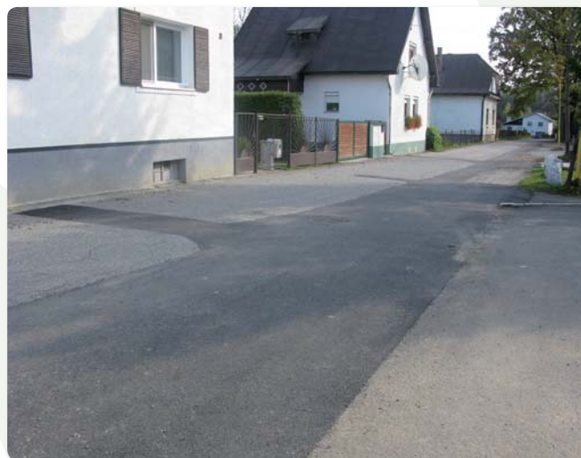
Ukončenie výstavby časti stokovej siete
