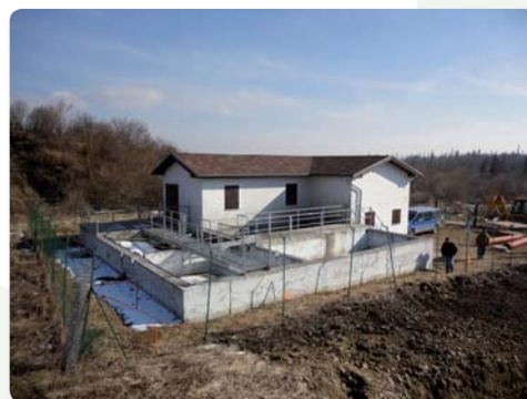
Realizácia výstavby ČOV
